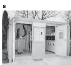
Рис. В38: Четыре конструкции по стандарту МЭК 62271-202, две из них: а подстанция высокого/низкого напряжения с доступом людей; б полуподземная подстанция высокого/низкого напряжения
