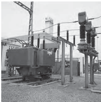
Рис. B25: Расширитель для масла с воздушной подушкой при атмосферном давлении
