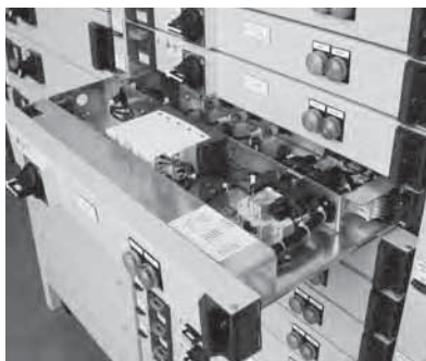
Рис. E32 : РУ с выдвижными функциональными блоками
