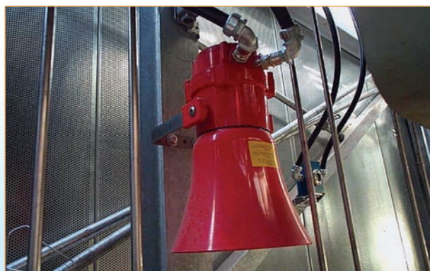
Звуковое оповещение на газовой электростанции: звуковой оповещатель BExS 120 ATEX
