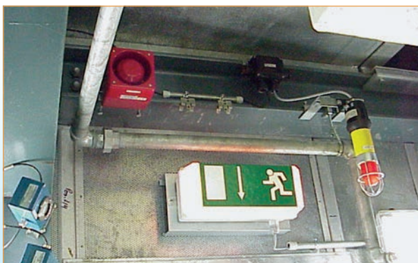
Распознавание газа со световой и звуковой сигнализацией: звуковой оповещатель DS 10 ATEX и проблесковая лампа CWB-ATEX
