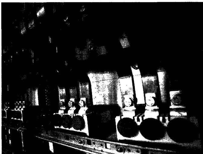
Рис. 3.41. Пример применения шинного монтажа в распределительном щите
