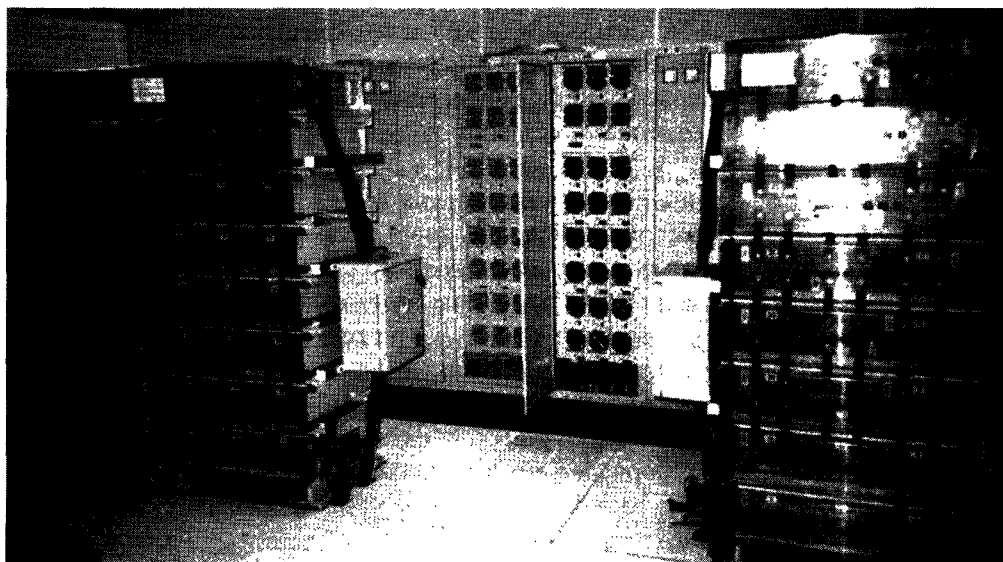
Рис. 8.2. Размещение системы постоянного тока (источник: APC)
