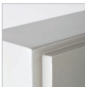
Полностью проваренные швы.
