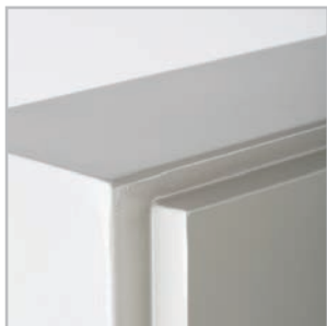
Полностью проваренные швы.
