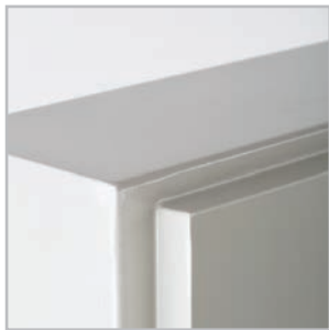
Полностью проваренные швы.
