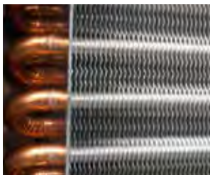
Большое расстояние между ламелями конденсатора
