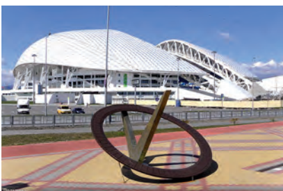
Стадион "Фишт" г. Сочи. Кабель-канал "In-liner Front"
