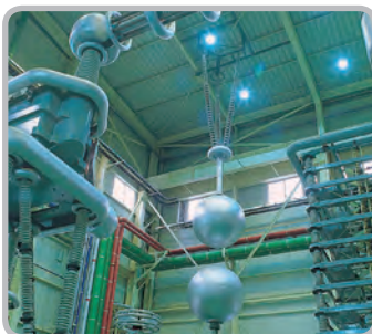
Испытание импульсом в лаборатории высоких напряжений
