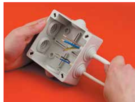
3 этап. Ввод кабеля
