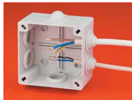
3 этап. Ввод кабеля
