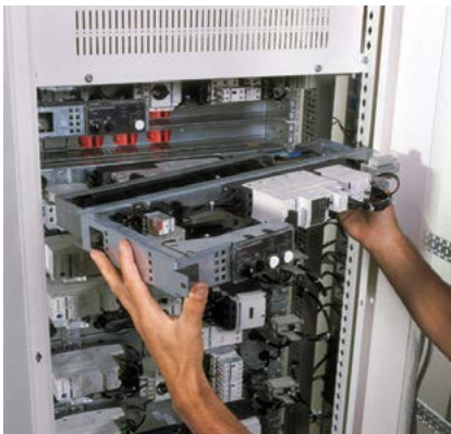
Рис. E31. РУ с вытчными функциональными блоками
