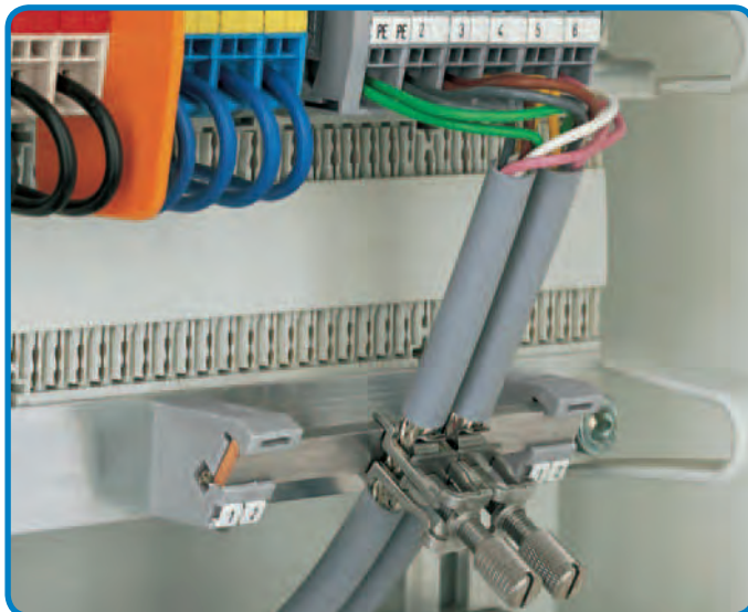
- изолированные монтажные держатели для опорного потенциала стандартного экрана независимо от потенциала корпуса
