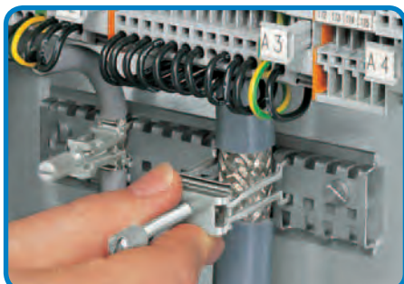
Добавление экранирующей зажимной скобы.
