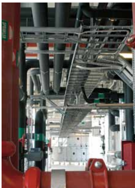
Кабельные лестницы WIBE KHZP, смонтированные в Научно-исследовательском центре в г.Чиста, Швеция
