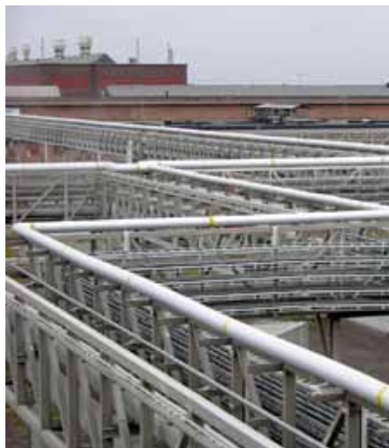
Кабельные лестницы WIBE KHZV, смонтированные на заводе Outokumpu по производству нержавеющей стали в г. Авеста, Швеция.
