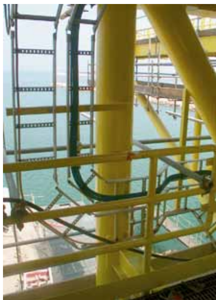
Кабельные лестницы WIBE KHZP с покрытием Zinkproх®, смонтированные на буровой платформе BP/ARCO/Technip на морском нефтяном месторождении Al Rayyan, Катар.
