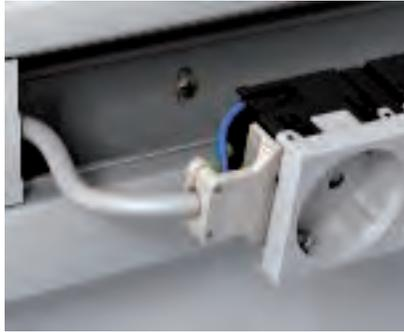
**Использование фиксатора для разгрузки кабеля от натяжения**
