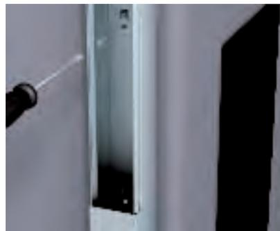
**Монтаж кабельного короба в помещениях с производственным оборудованием**
